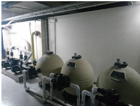
Fotografía 13. Sistema de tratamiento de aguas lluvias -Edificio Elemento
